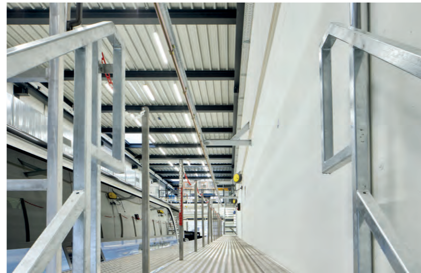
Die Arbeitshöhe kann je nach Kundenanforderung und örtlichen Begebenheiten individuell variieren – üblicherweise zwischen 2 und 3.50 Metern.
