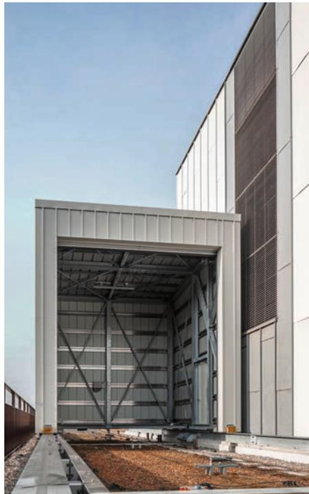
Die Garage bewegt sich auf einem rund 28 m langen Schienensystem, angetrieben von einem Elektromotor mit Seilzug und Umlenkvorrichtung.
