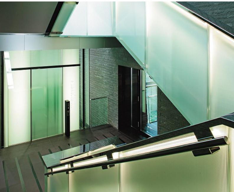
Treppenseitig sorgen Edelstahl-Handlaufprofile für einen sicheren Gang. Côté escalier, des profilés pour main courante en acier inoxydable permettent de monter et descendre en toute sécurité.
