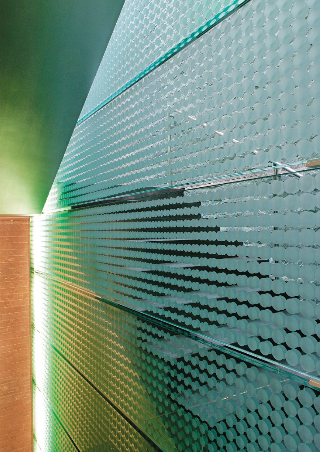
Der Glasschild im Treppenauge führt über 8 Stockwerke. Das Glas alleine wiegt rund 9,5 Tonnen. Le panneau de verre dans la cage d'escalier s'élève sur 8 étages. Le verre seul pèse environ 9,5 tonnes.
