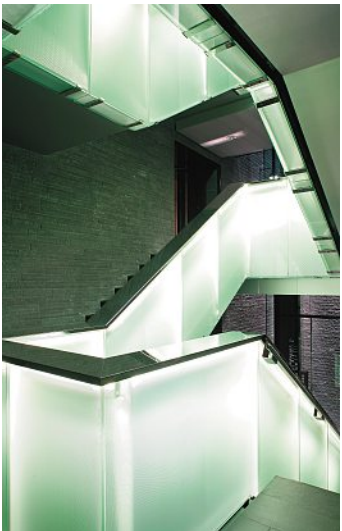
Treppengeländer als imposanter Lichtspender im Treppenhaus. La rampe d'escalier, élément imposant dispensant de la lumière dans la cage d'escalier.
