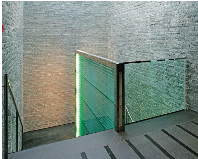
Oberer Abschluss des Glasschildes: Eine einzelne Glaslamelle wiegt rund 200 kg. Die Sandstrahlung reflektiert und leitet das Licht aus dem Seitenprofil über das Glas.
