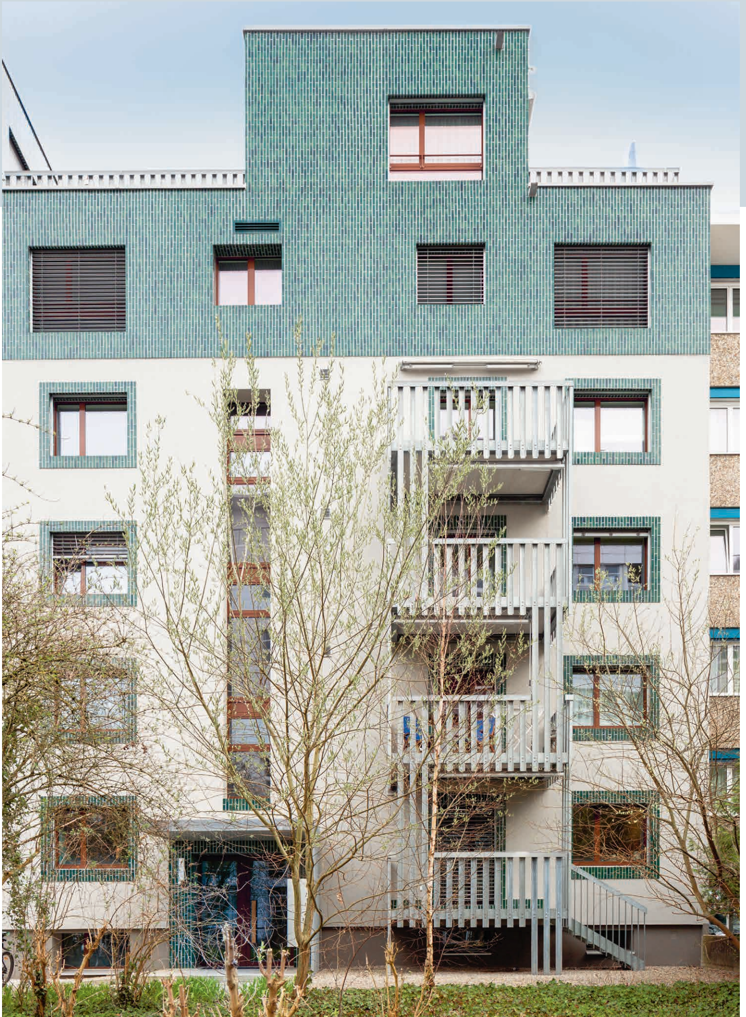
Die UNP-100-Lisenen mit ihren nach aussen gerichteten Schenkeln prägen das Erscheinungsbild der Balkonbauten. Les lésènes en UNP 100 aux ailes orientées vers l'extérieur caractérisent l'aspect visuel des balcons annexes.
