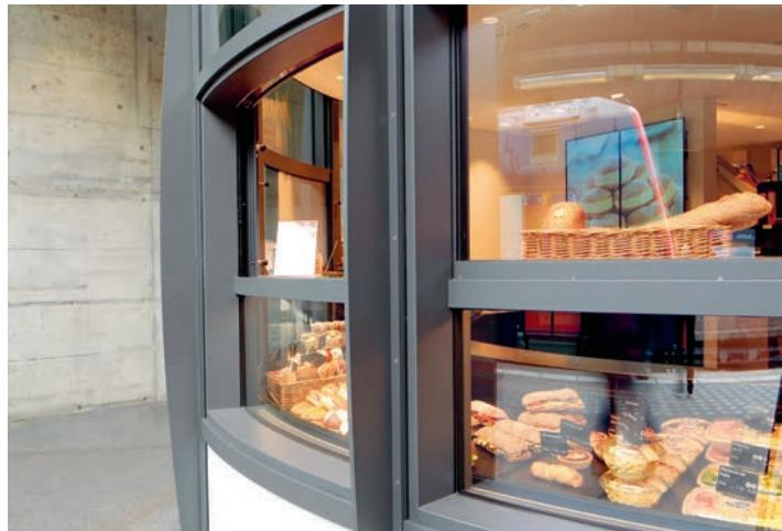
Die Blaser Metallbau AG entwickelte die Hubfenster speziell für dieses Objekt. Jeder der fünf Flügel lässt sich manuell - mit einem Handgriff - und beinahe widerstandslos nach oben schieben.
