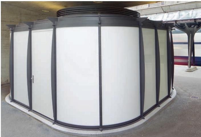
Als Personaleingang dient eine im Mittelfeld der Rückseite eingebaute, thermisch getrennte Einflügeltüre. Rahmen und Flügeltüre sind ebenfalls komplett mit dem weissen Glas belegt.
